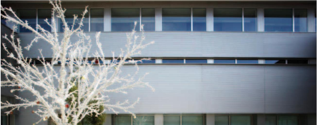
Falkit® es un sistema de revestimiento de todo tipo de superficies basado en lamas de aluminio machihembradas. Su simplicidad de montaje, variedad de perfiles y adaptabilidad le confieren una gran versatilidad, pudiéndose adecuar a múltiples aplicaciones:
