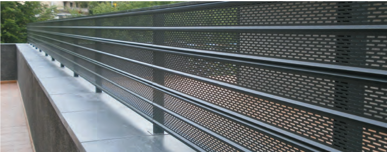
Sierra Morena Perforado Viviendas - Sukarrieta (Vizcaya)
